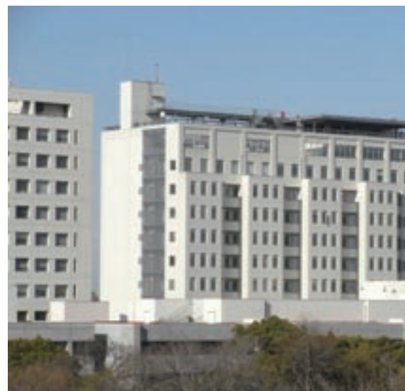
ヘリポートを備えた新病棟(ひがし棟)
